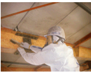
石綿の除去作業と防護服
